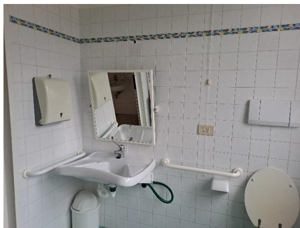
Servizio igienico accessibile al piano terra
