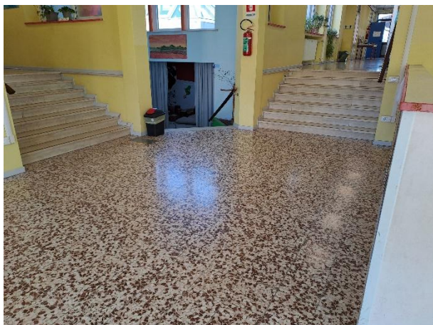
Vista generale delle scale di accesso alle aule
