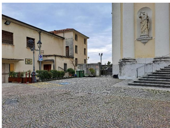
Parcheggio e accesso alla Chiesa
