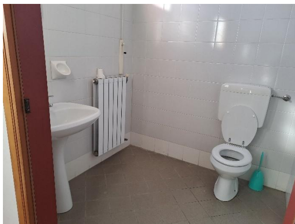
Servizio igienico spogliatoio 2
