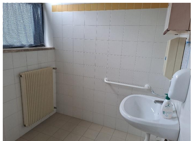
Servizio igienico accessibile al piano secondo
