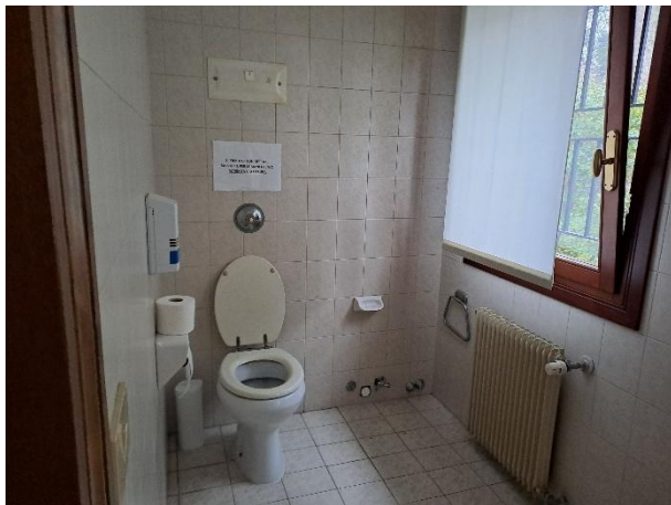
Servizio igienico al piano secondo
