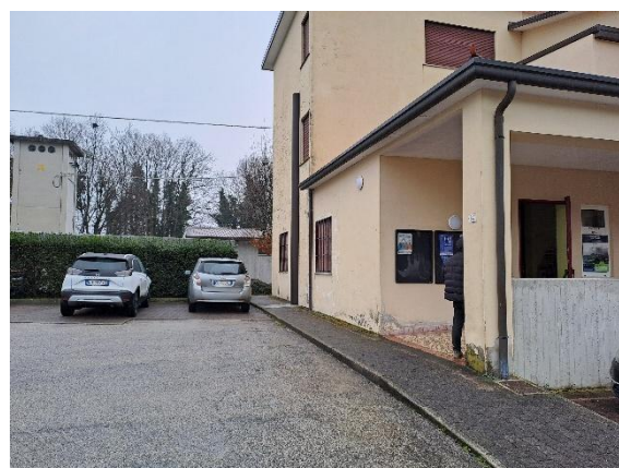
Posto auto esterno da adibire per disabili
