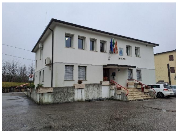
Vista generale da Nord-Ovest
