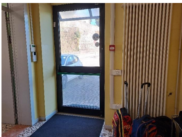
Accesso al parcheggio retrostante il fabbricato
