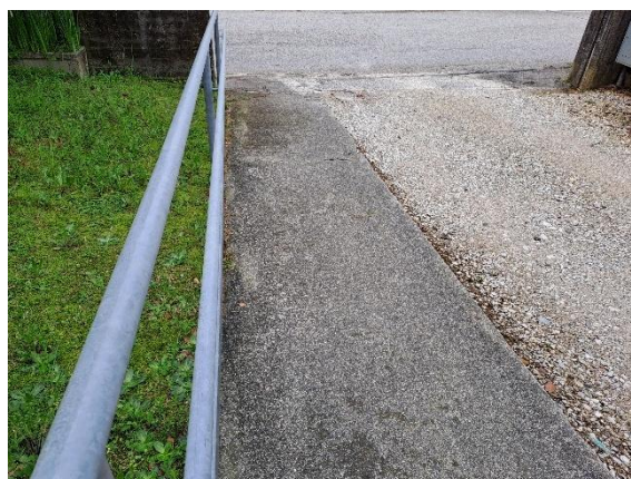
Accesso alla rampa
