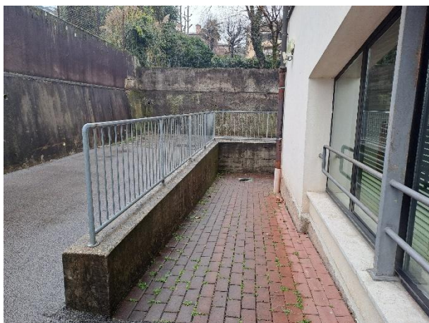
Rampa di accesso al piano terra
