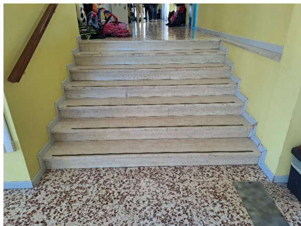
Scala di accesso alle aule
