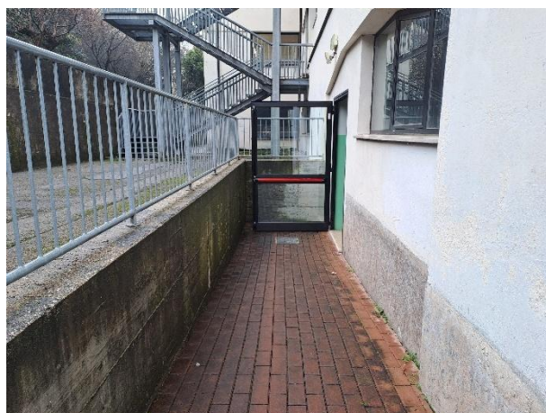
Rampa di accesso al piano terra
