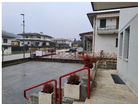
Vista del parcheggio esterno e della rampa
