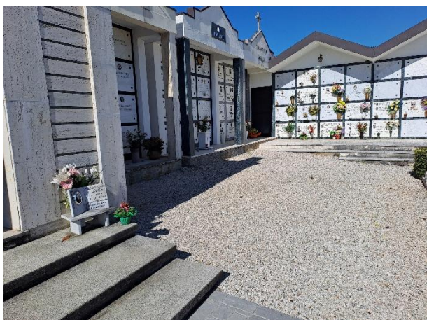
Area di realizzazione del servizio igienico
