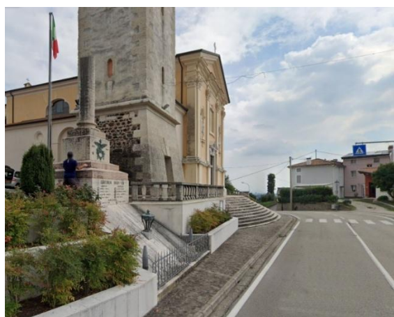
Vista generale da Nord
