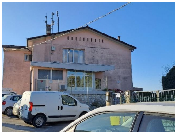
Vista generale e parcheggio
