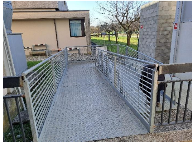
Rampa per l'accesso all'aera esterna
