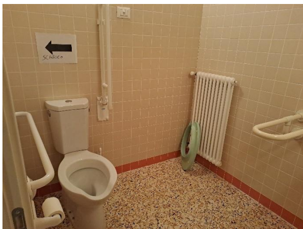
Servizio igienico accessibile al piano terra
