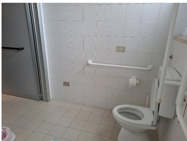
Servizio igienico accessibile al piano secondo
