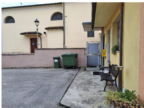
Piattaforma elevatrice per l'accesso al cimitero
