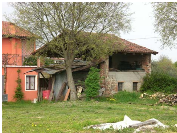
Intervento 1: edifici da demolire
