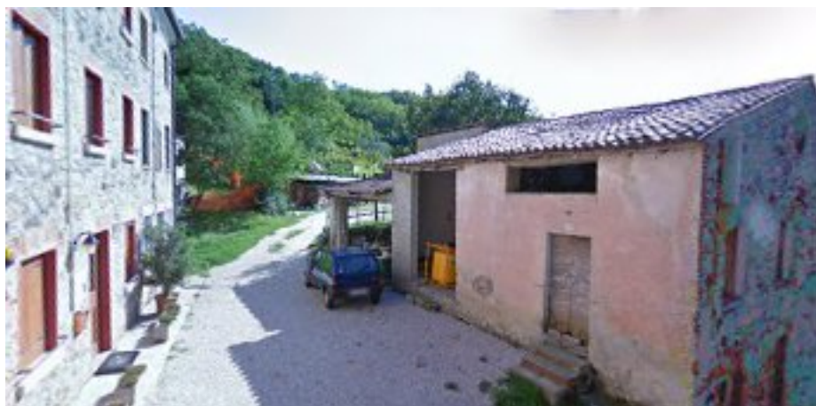
Intervento 15: edificio in demolizione
