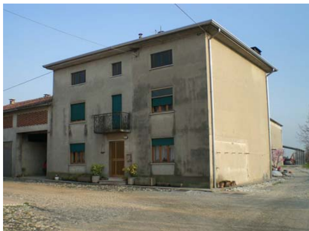
Intervento 11: edificio in demolizione
