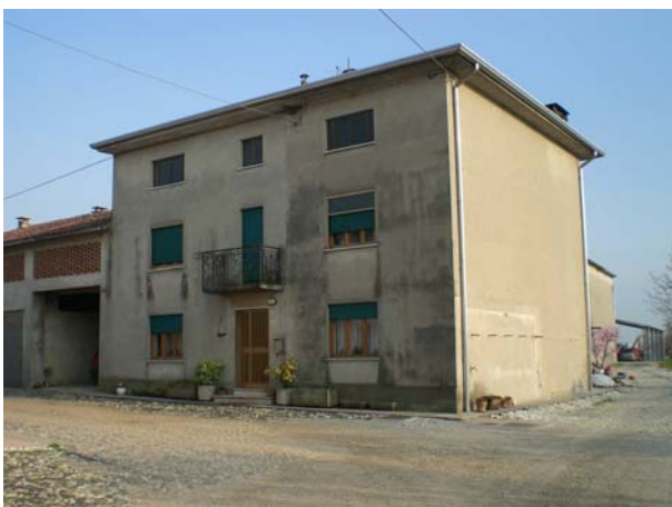
Intervento 11: edificio in demolizione
