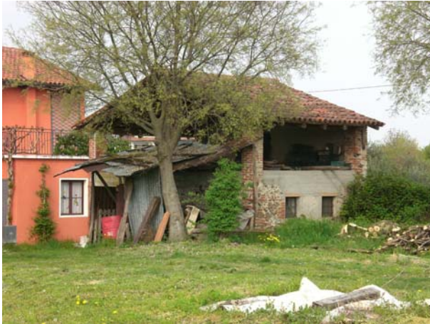
Intervento 1: edifici da demolire
