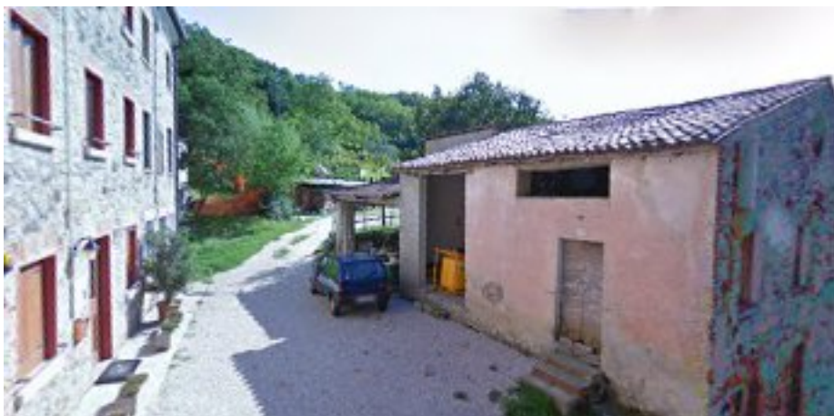
Intervento 15: edificio in demolizione
